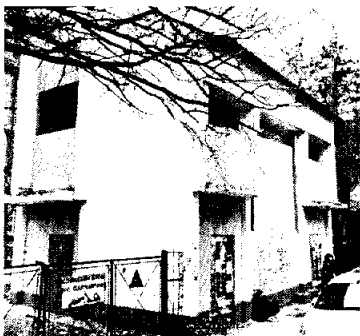
фиг.1а. Възлова станция 20kV "Булаир"
